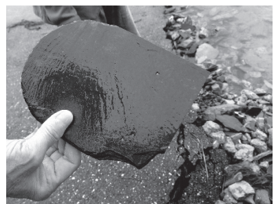
Fig9 流出瓦の拡大図 (筆者撮影、2012年当時の状況)
