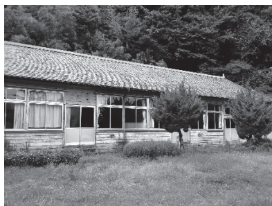
Fig7 スレート屋根 (筆者撮影、2014年) 現在はモリウミアス施設に改修されている
