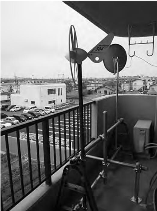
図1 集合住宅ベランダ部分への風力発電装置の設置
