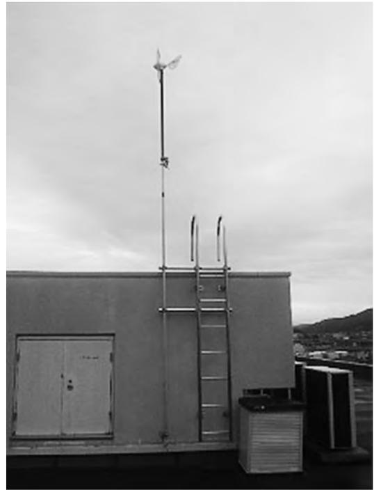
図2 1号館屋上部分への風力発電装置の設置
