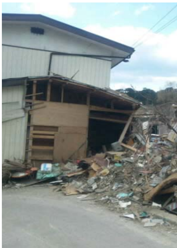
道路上に建つ祖父母宅（桂島）
