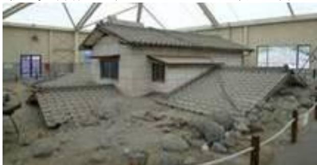
土石流被災家屋保存公園(南島原市)
