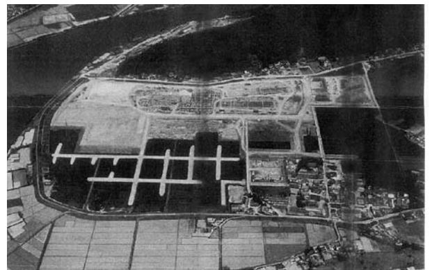
昭和63年5月 校舎部の集中盛土が終わり、建築基礎工事施工中
