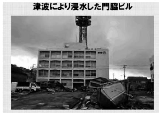
写真1. 電力設備が津波により浸水する一方で、通信設備については上位階にあったため、浸水を免れた。 (東日本電信電話株式会社が公表した資料より)
