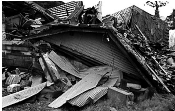
宮城県北部連続地震による被害
