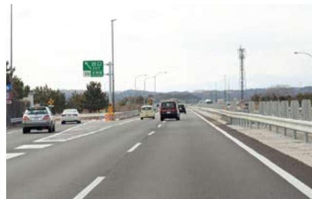
4車線化された三陸自動車道(石巻港付近)
