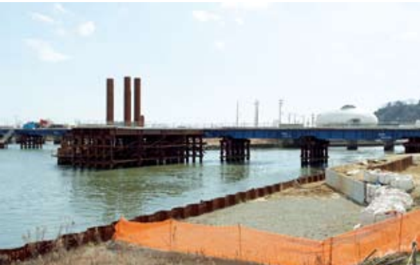
架け替え工事の中の新内海橋
