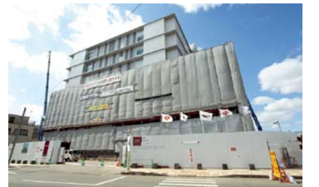
石巻駅前に建設中の新石巻市立病院
