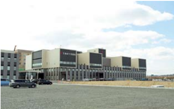
既存棟の改修工事が進む石巻赤十字病院
