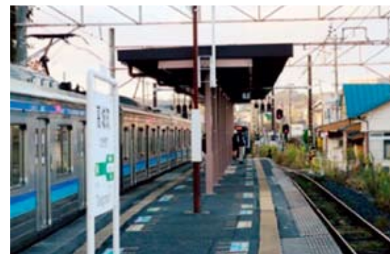
屋根が設置された高城町駅 (平成27年11月11日)
