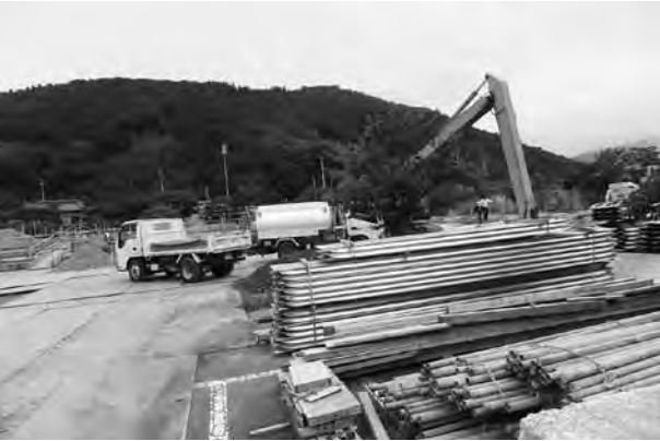
平成26年8月19日 足場用の資材の搬入
