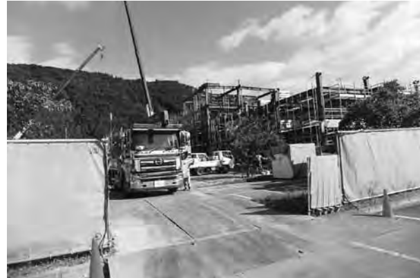
平成26年9月18日 宿舎3階部分まで鉄骨が組み上げられ始める
