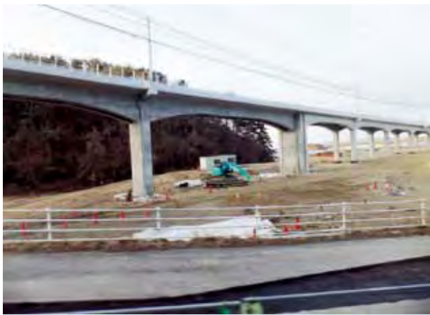
完成した陸前大塚駅-新・東名駅間の高架線(平成27年1月28日)
