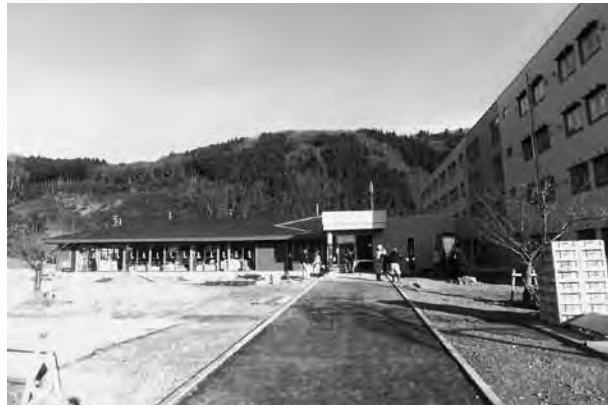
平成27年1月21日 食堂部分も外観がほぼ完成
