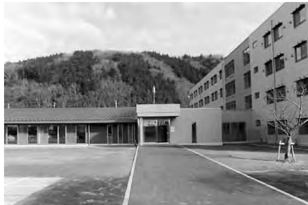
平成27年2月25日 建物はほぼ完成し、前庭が整備されつつある
