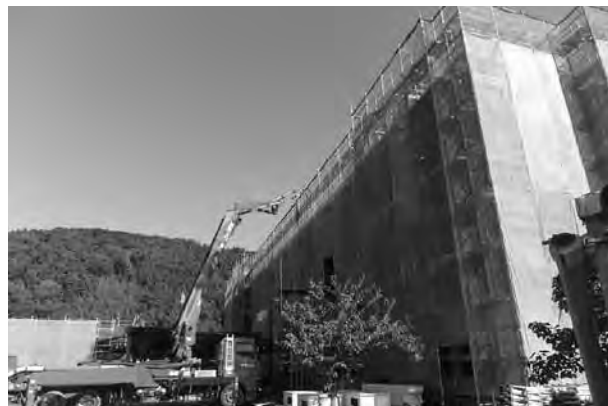
平成26年10月15日 宿舎壁面の取り付けコンクリート注入
