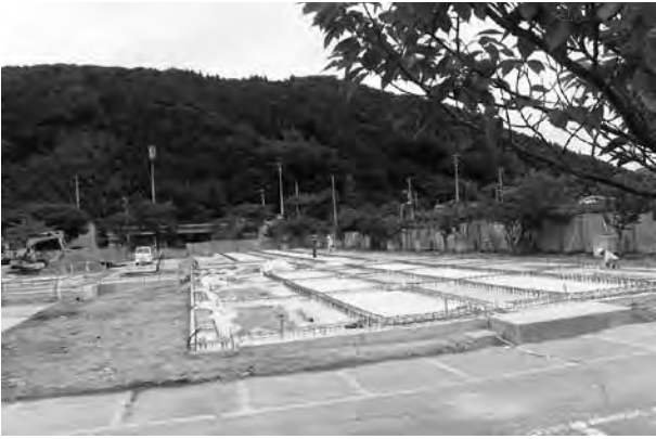
平成26年9月4日 コンクリートで固められた基礎部分
