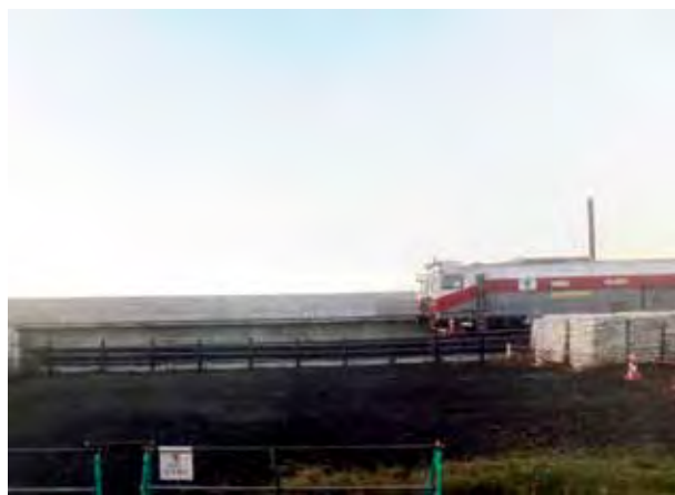
かさ上げされた陸前大塚駅付近に停車する工事用車両(平成26年11月18日)
