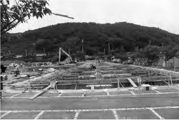
平成26年8月8日 宿舍部分のコンクリート注入枠工事
