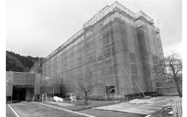
平成26年12月11日 宿舎部の壁面がほぼ完成
