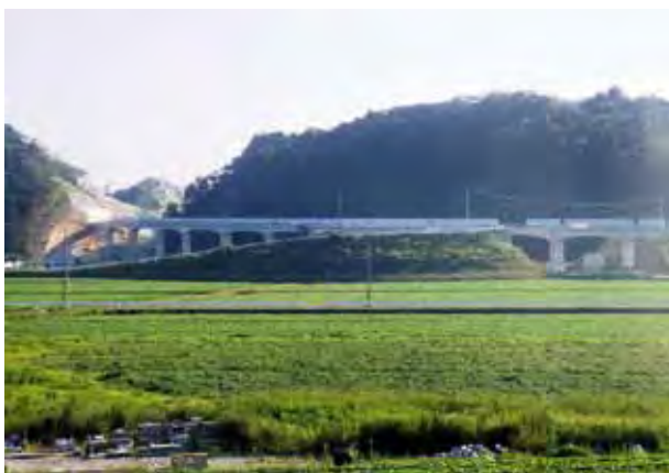
鳴瀬川鉄橋からの新・野蒜駅方面への高架新線工事(平成26年8月3日)
