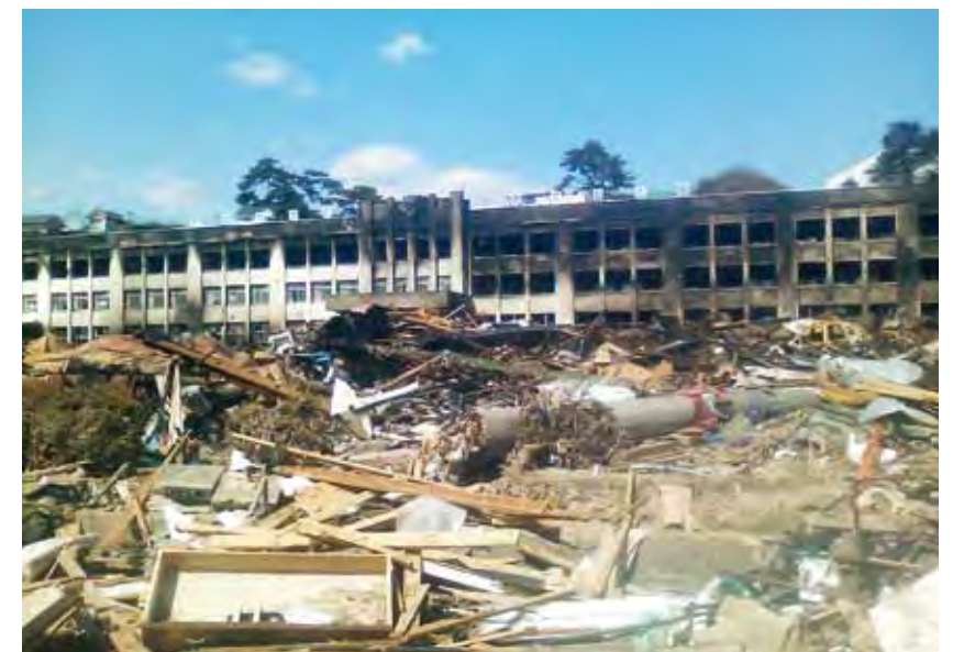
▲津波と火災で廃墟と化した石巻市立門脇小学校(3月19日)
