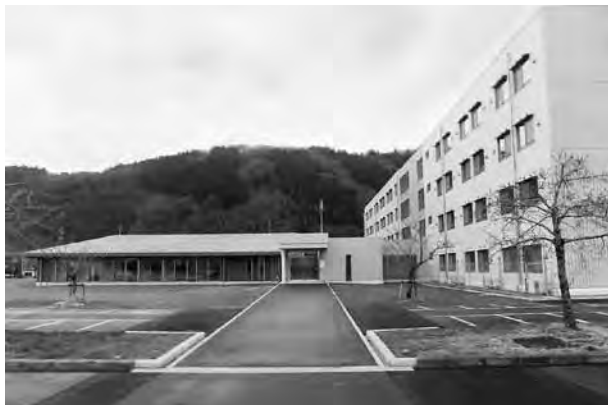
平成27年2月23日 柱の養生もはずされほぼ完成形に近づいた
