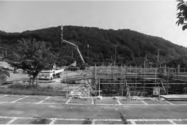
平成26年7月29日 宿舍部分の基礎工事
