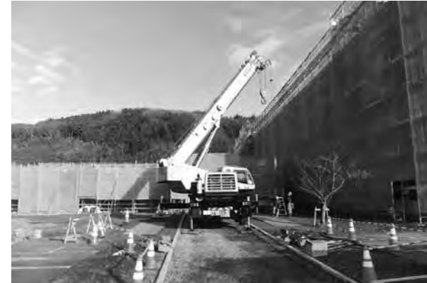
平成26年12月3日 巨大なクレーンが作業中
