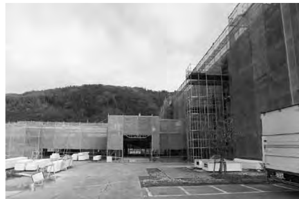
平成26年11月11日 食堂部分の壁面パネルが積まれている
