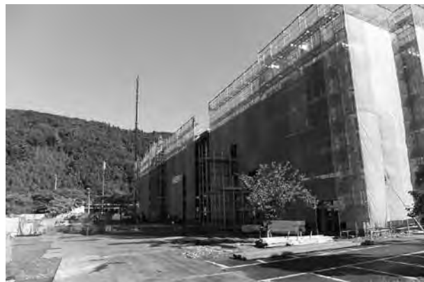
平成26年10月7日 全体がシートで覆われ側面の工事が始まる
