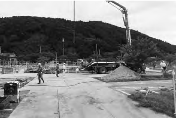
平成26年8月27日 巨大なクレーンによる基礎部分への生コンの注入
