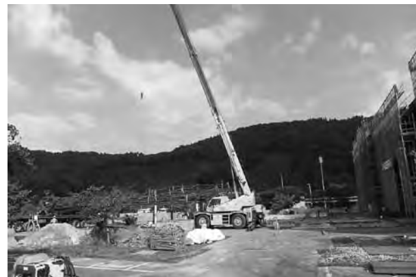
平成26年10月9日 食堂部分の鉄骨の組み上げ
