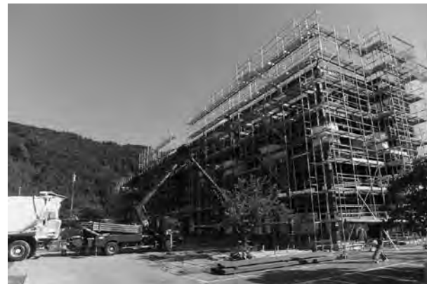
平成26年9月30日 宿舎下部にコンクリートが注入される
