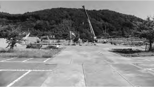
平成26年7月25日 食堂部分の基礎工事
