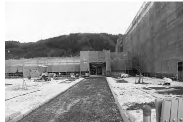
平成26年12月17日 食堂の入り口にガラス扉が設置されている
