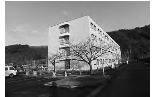
平成27年1月16日 宿舎の外観がほぼ完成した
