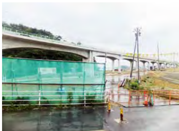
陸前大塚駅-新・東名駅に建設された高架線(平成26年7月23日)
