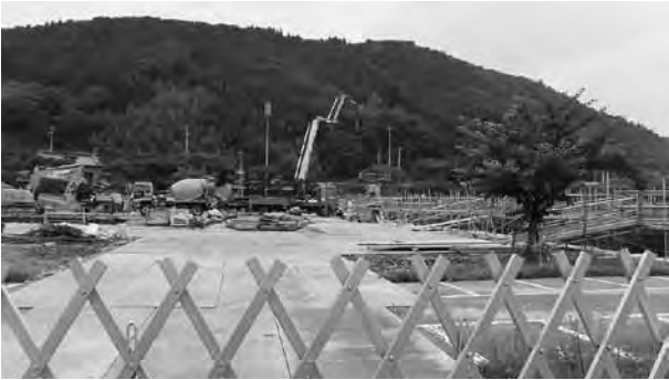
平成26年7月23日 基礎工事(宿舍北側へのコンクリート注入)
