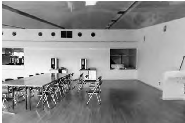
平成27年2月25日 食堂部分の内装もかなりできあがってきた
