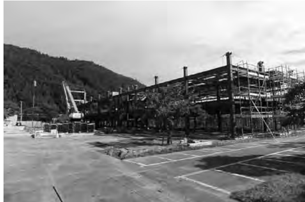
平成26年9月16日 宿舎全体の鉄骨の2階部分まで鉄骨が組み上がる
