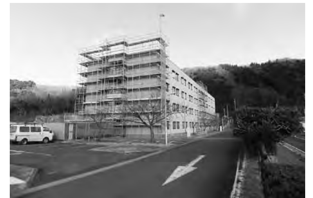
平成27年1月7日 全体のシートが撤去され、全貌が明らかになった
