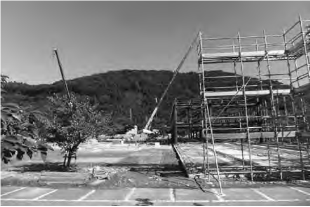
平成26年9月12日 宿舍北側の2階部分の鉄骨が組まれる
