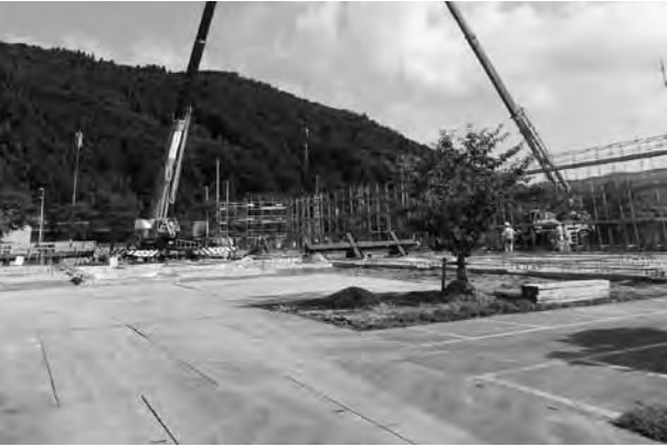
平成26年9月9日 宿舍部分の鉄骨の組み立てがはじまる
