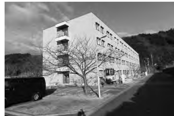
平成27年1月13日 足場が撤去されきれいな外観を表す
