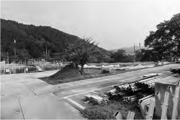
平成26年8月25日 基礎部分のコンクリート注入枠が完成
