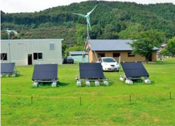
図1 風力・太陽光ハイブリッド自家発電システム
