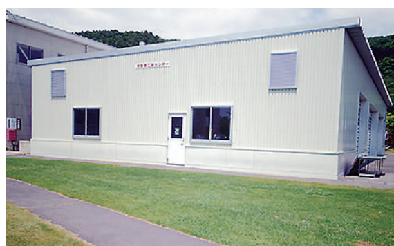
自動車工学センター外観
