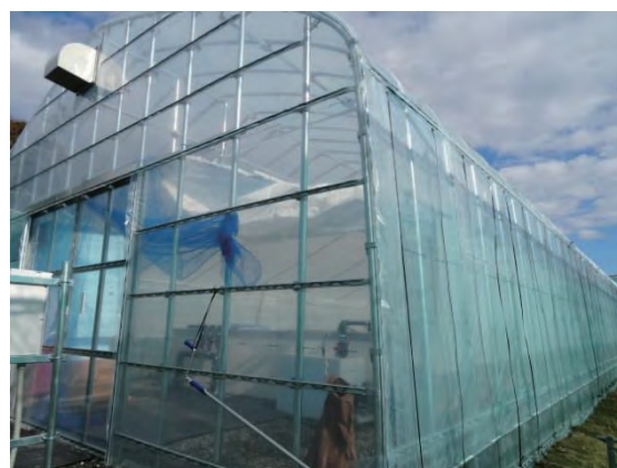
ビニールハウス完成
