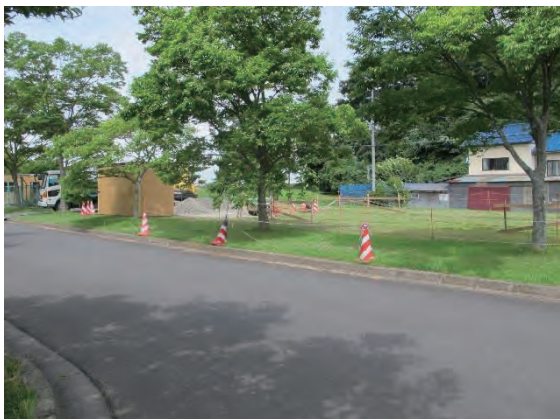
大型養殖水槽工事着工
