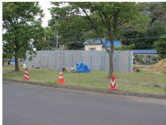
水槽土台部分①
