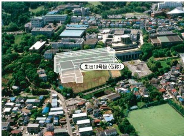
生田キャンパスの生田10号館（仮称）建設予定地
