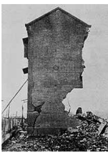
外壁1枚を残して 崩れ落ちた図書館書庫
