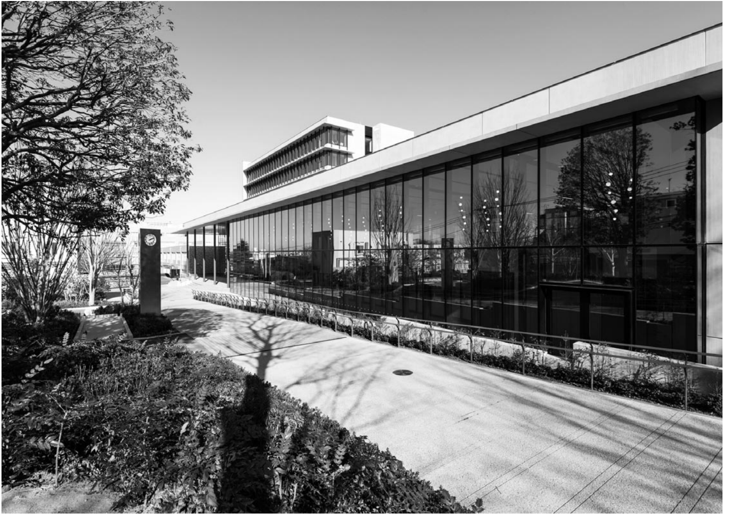
2号館3号館（奥）（生田キャンパス）
