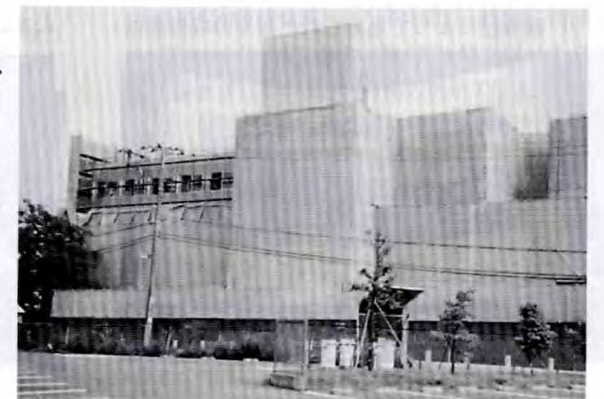
改装中の「生田分館」
