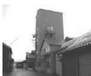
北館醸造工場 富山県湯川町 1仕込数量 500k 年間製造能力 20k
