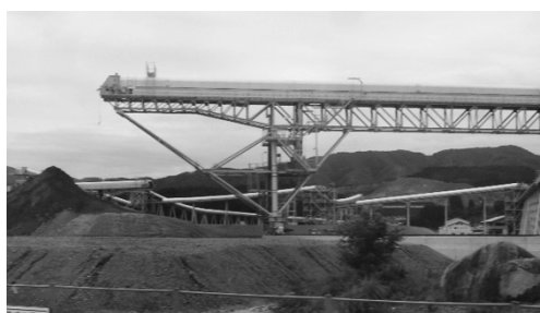
写真 ベルトコンベアで運ばれた 土砂で作られた盛り土
