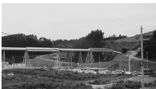
写真 丘陵地の土砂を運ぶベルトコンベア (2014. 8. 27)
