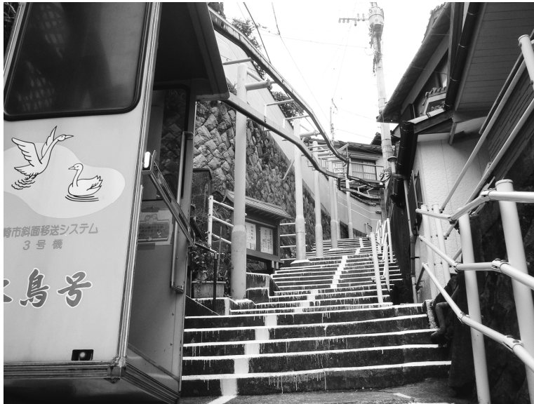
写真3 水の浦町の斜面移送器機（高齢者用、2004年設置）
