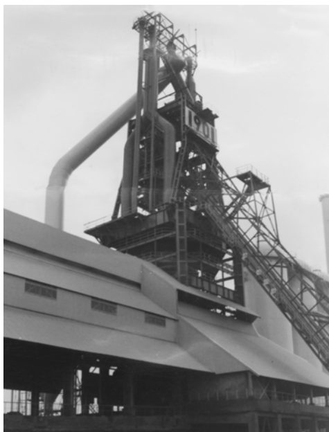
写真 27 東田高炉（官営八幡製鉄所でまず最初に建設されたもの）当時の一大ナショナル・プロジェクトで建設中伊藤博文を中心に写した写真がある。現在、北九州市に寄贈された。
