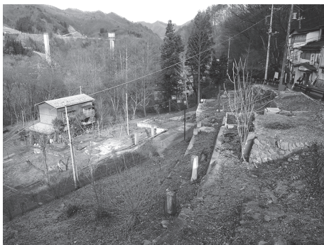
写真 12 2012 年 10 月 旅館の取り壊しの進む川原湯温泉
