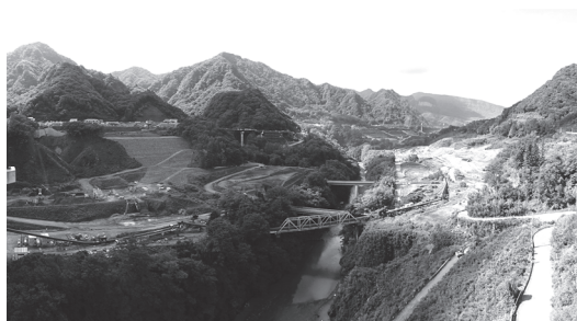
写真 15-2 2018 年 9 月 建設途上のダムの内側 (水没する吾妻溪谷と川原湯地区)
