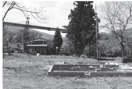
写真 11 2010 年 5 月 水没集落の家屋撤去と建設中の湖面大橋
