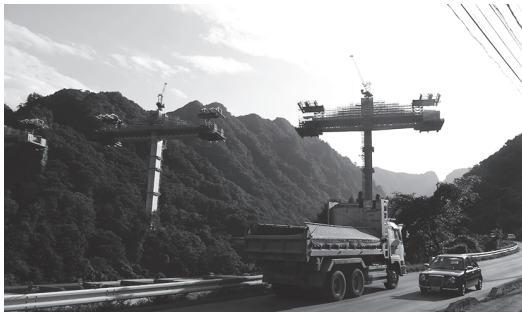
写真 10 2009 年 9 月 ハツ場ダム湖面 2 号橋の建設
