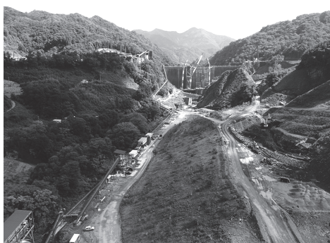
写真 15-1 2018 年 9 月 建設途上のダム
