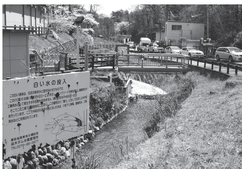
写真 1-2 湯川に流される石灰水
