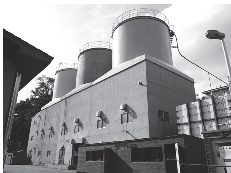
写真 1-1 国土交通省関東地方整備局 品木ダム水質管理所の石灰貯蔵タンク
