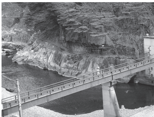
写真 7. 県境付近の渡良瀬川岸の岩盤を削って軌道を通した足尾馬車軌道の片マンブ（左上に見える現在の線路は笠松トンネルに入る）
