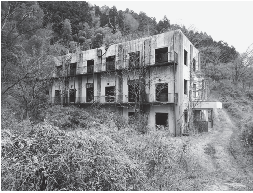
写真 10. 神戸発電所跡に廃墟に残る建屋
