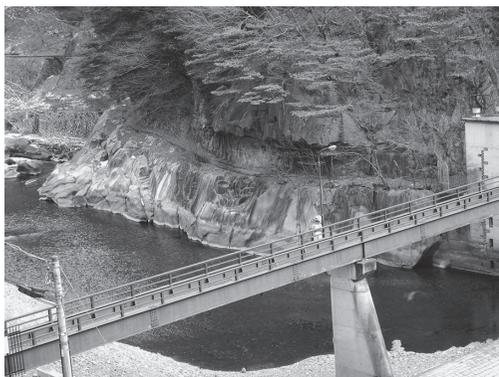
写真 7. 県境付近の渡良瀬川岸の岩盤を削って軌道を通した足尾馬車軌道の片マンブ（左上に見える現在の線路は笠松トンネルに入る）
