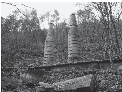
写真 14. 上信鉱山の現地に 2 本残る煉瓦の焙焼炉 （嬭恋村干俣、2014.11.7）
