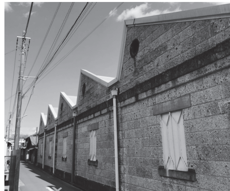
重要伝統的建造物保存地区内の旧工場
