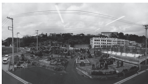
写真 9 事務所の窓から遺構の門脇小学校
