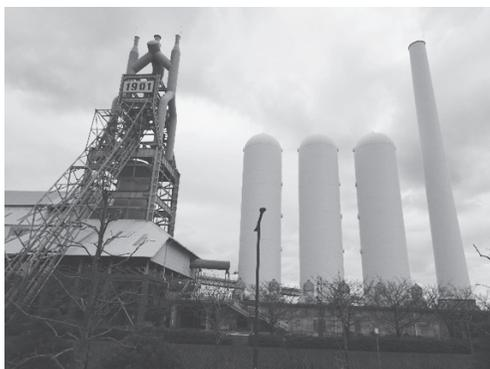
写真10：左が10代目の高炉、右が熱風炉
