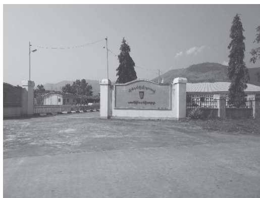
b. 移転先に建設された病院
