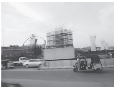
写真3. 建設中のコロンボ市内の高速道路
