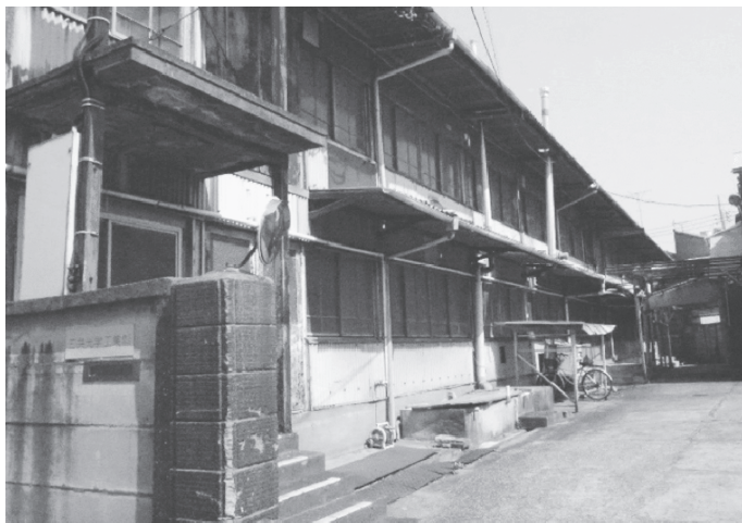
【写真 1】東京本社 三共光学工業発祥の地である東京事務所は豪華な建屋とは言えないがその歴史を物語る極めて質素な建屋である。
