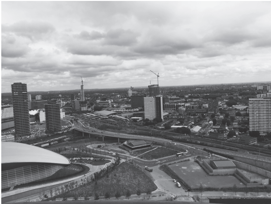
オリンピック後も周辺の開発が続いている（シンボルタワーから） （広瀬撮影 2016）
