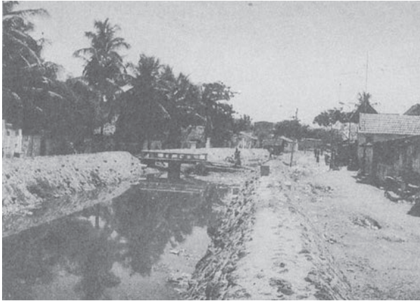
コーポレーション水路。洪水時には、1.5mの水位まで上昇
