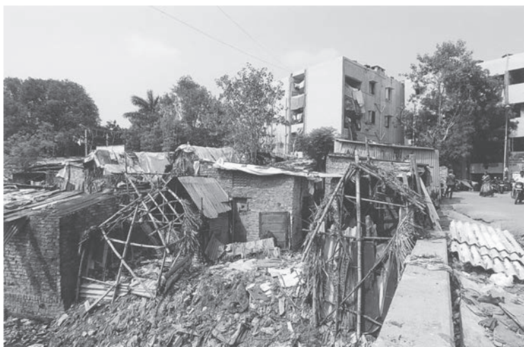
スラムの背後にある移転先の4階建て建物（3ヶ所）
