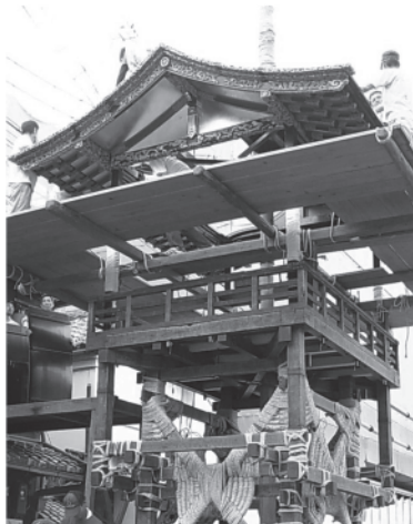
写真5：大工方作業：屋根部分の取付（筆者撮影）
