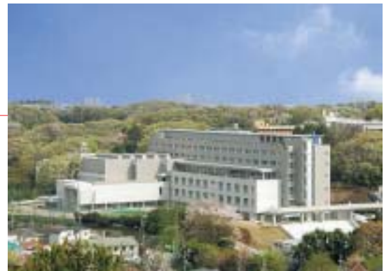
生田校舎10号館『専修大学130年記念館』 Ikuta Campus Building No.10 (130 Year Memorial Building)
