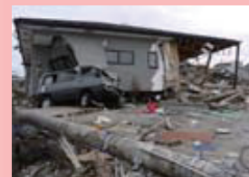
石巻渡波、津波に洗われた住宅地(2011.5.6)
