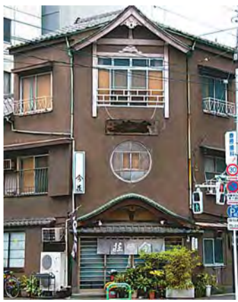
▲ 「うなぎ今荘」の店舗。屋根の形式は千鳥破風(3階)と唐破風(1階)。支える蛙股の装飾も珍しい
