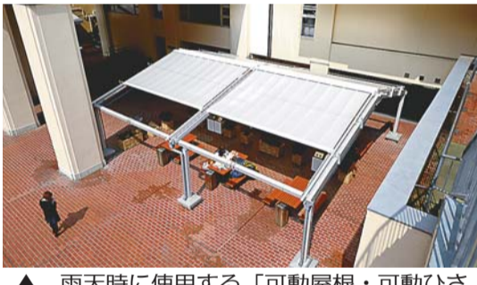
▲ 雨天時に使用する「可動屋根・可動ひさし」が設置された休憩スペース(2、3号館1階広場)
